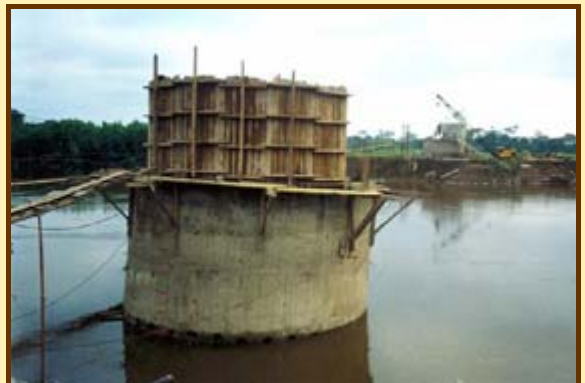
Foto-4 Vista de la margen derecha, del cajón inclinado dentro del río Yuracyacu.
