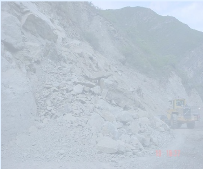
Foto-2: Cantera de roca alterada como material de construcción para el terraplén de la Carretera Chalhuanca-Abancay.
