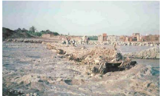
FOTO- 5: VISTA DE LAS CAUSAS DE LA INUNDACIÓN, EMPALIZADA DEL PUENTE ANTIGUO Y MALA LIMPIEZA DEL CAUCE 04/03/94 EN EL CALLAO,1994.(Foto A.M.V)
