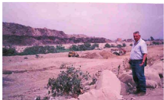
FOTO- 6: TRABAJOS DE EXCAVACIÓN DENTRO DEL CAUCE DEL RÍO RÍMAC- CALLAO, PERMANENTEMENTE RELLENADO DE SEDIMENTOS. (Foto-A.M.V)
